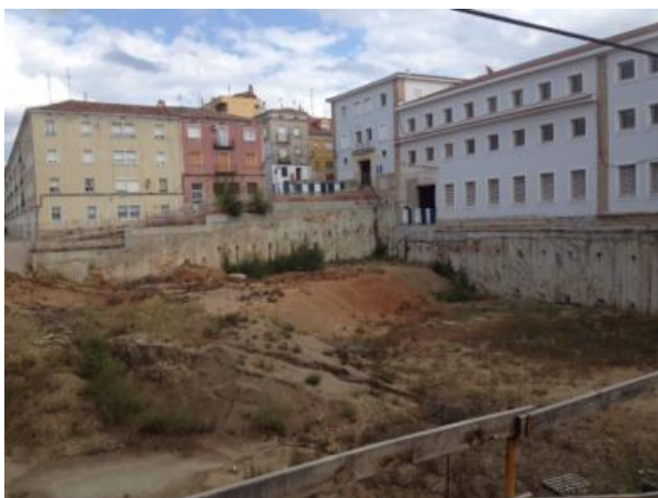
Fig. 2 El instituto en obras con su patio en primer plano. Foto: Voces de Cuenca, 30-01-2015.
